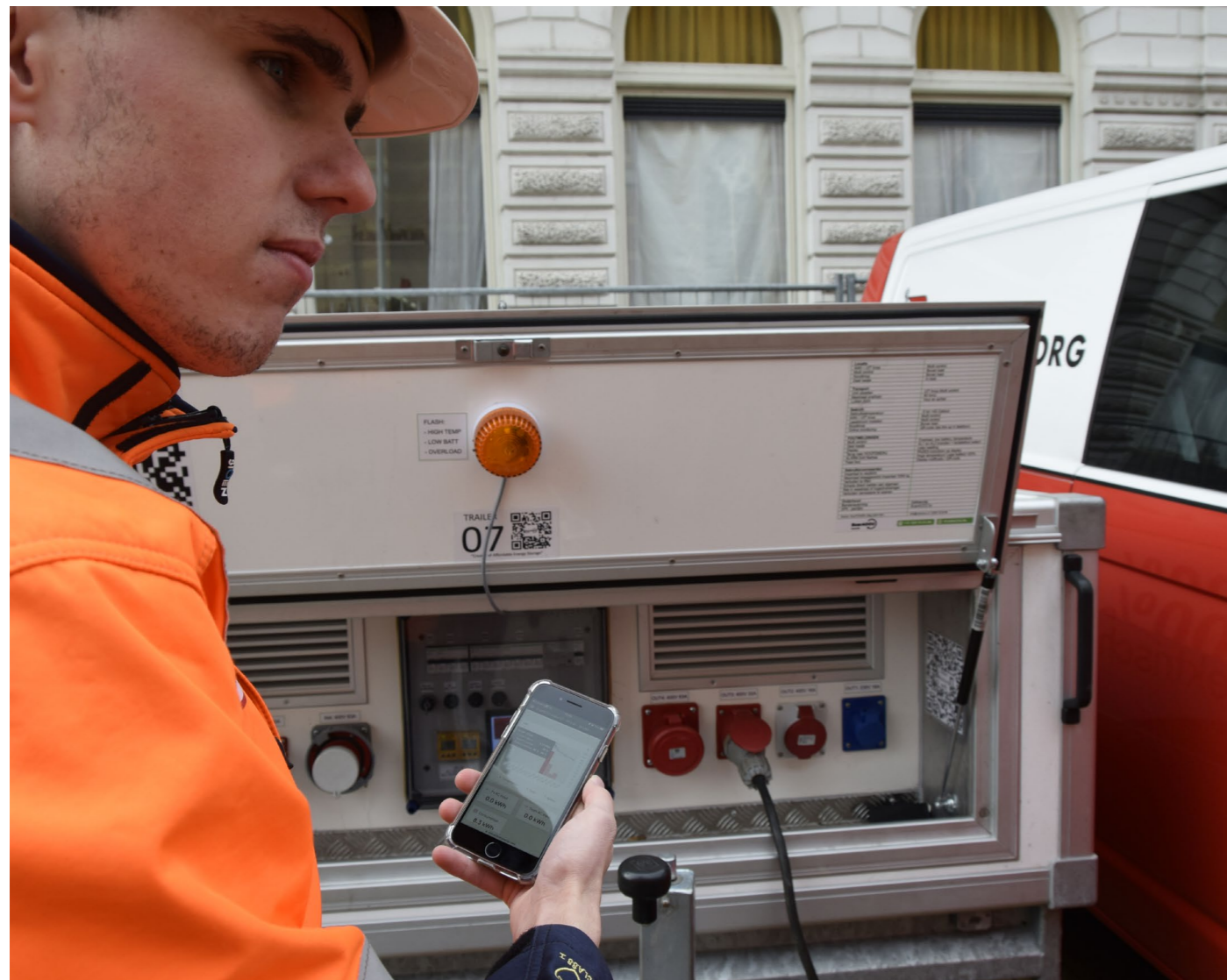
Einige unserer Turmdrehkräne laufen einen ganzen Tag lang mit Strom aus einem Akkswagen oder Baustrom.
